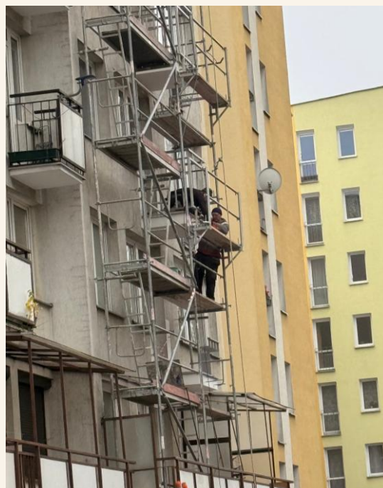
Remont balkonów prowadzony w 2025 roku – prace miały na celu poprawę bezpieczeństwa i stanu technicznego budynków.
